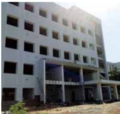
建設中のフエ医科薬科大学の別棟 この建物の教室を借りて介護教室を開講します。
